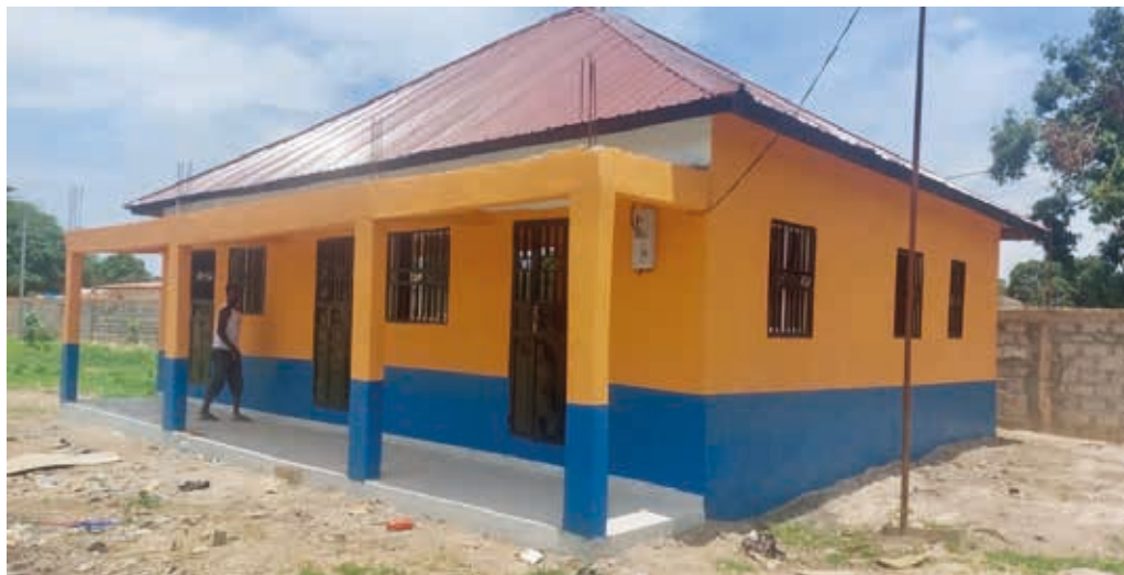
Det nye klubbhuset til ScanAid Football Academy. Vi skjønner godt at renere og spillere gleder seg til å ta det nye anlegget i bruk
